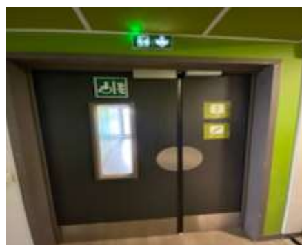
Porte coupe-feu et éclairage de sécurité
